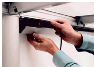
Johdot voidaan kuljettaa kätevästi johtokourussa.
