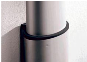
Jalan alumiininen suojakuori kiinnitetään seinään.
